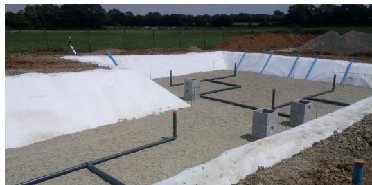
Réhabilitation de la station de la Padiolière à Saint Lumine de Coutais
