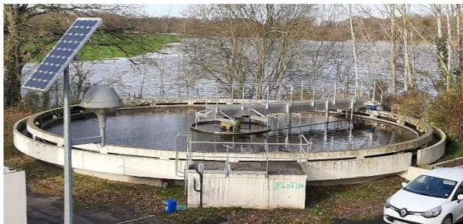
L'admission de l'eau en provenance de l'aération se fait par un orifice noyé puis un tuyau vertical. L'entrée de l'effluent dans la clarificateur est protégée par une cloison siphonide.
