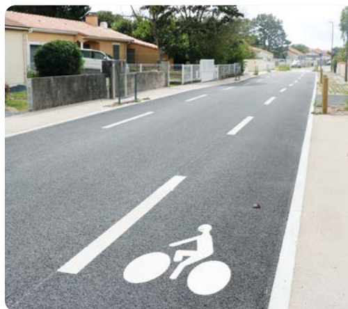
La commune de Geneston a bénéficié du soutien de Grand Lieu Communauté pour la réhabilitation de la rue des Ajoncs.
