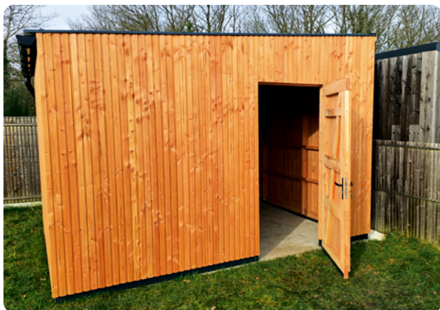
Anthony Veillard a lancé son entreprise Veillard Construction Bois à La Chevrolière, et réalise des projets sur-mesure auprès de particuliers.
